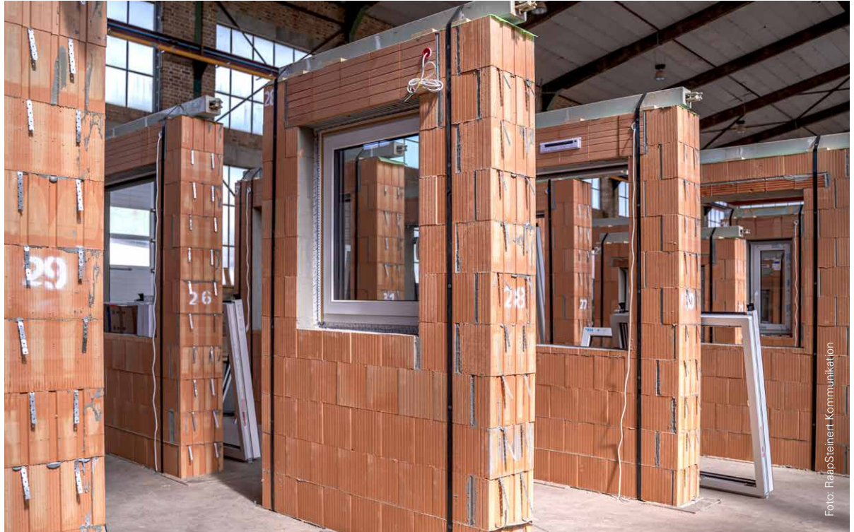
Ziegelfertigteile inkl. Fenster
