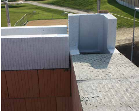
3. Vorbereitung von Detailanschlüssen: Ecken
