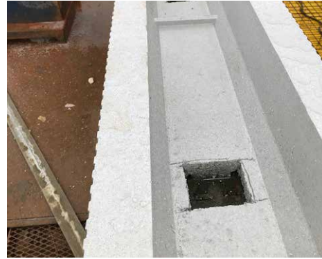
2. Vorbereitung Fußfette, Mittelfette und Giebfette. Boden muss entsprechend der statischen Vorgaben ausgeschnitten werden, um Verbindung zum Mauerwerk herzustellen. Leichte Einbindung der SD-Schale möglich.
