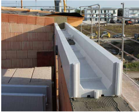
1. Verarbeitung mit Dünnbettmörtel oder vergleichbar
