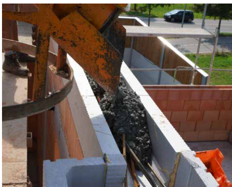
5. Betonieren und austrocknen lassen
