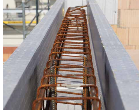
4. Bewehrung nach statischen Vorgaben einlegen
