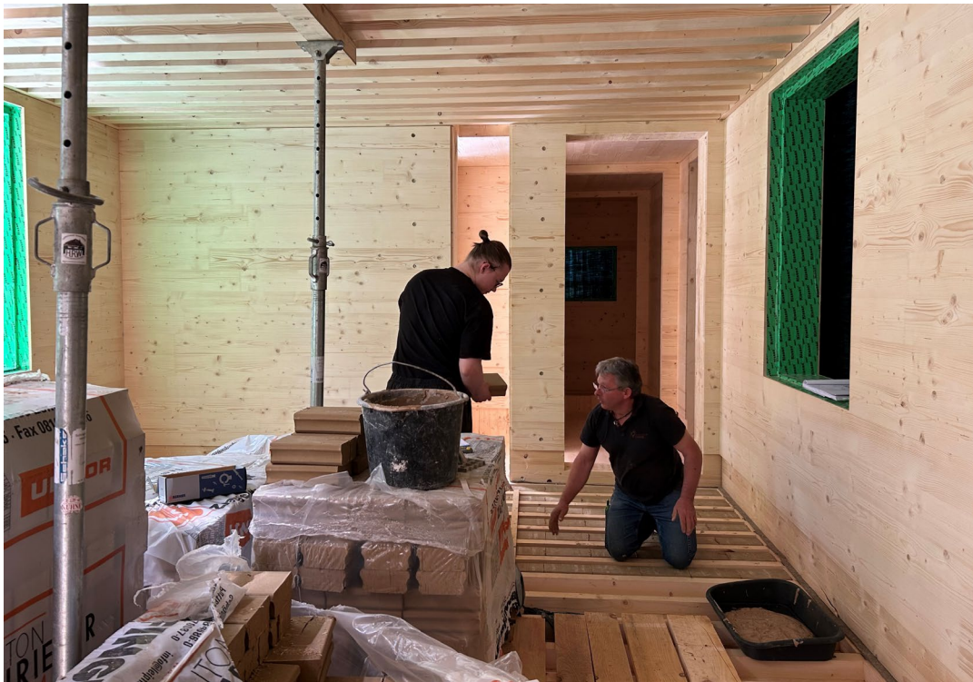
a) Einlegen der Deckensteine in Situ
