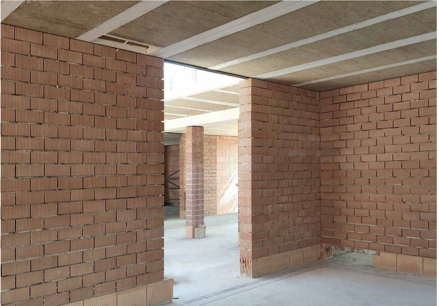
Das Gebäude im Rohbauzustand
