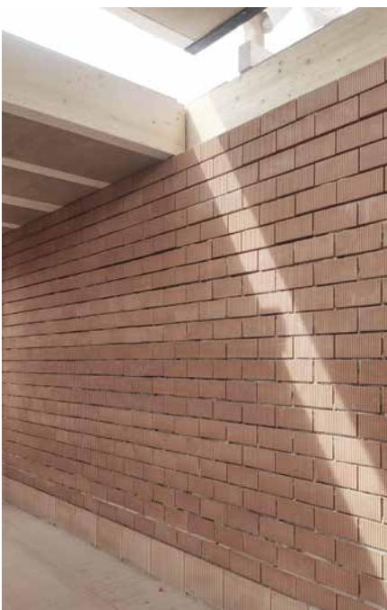
Montage eines Deckenelements
