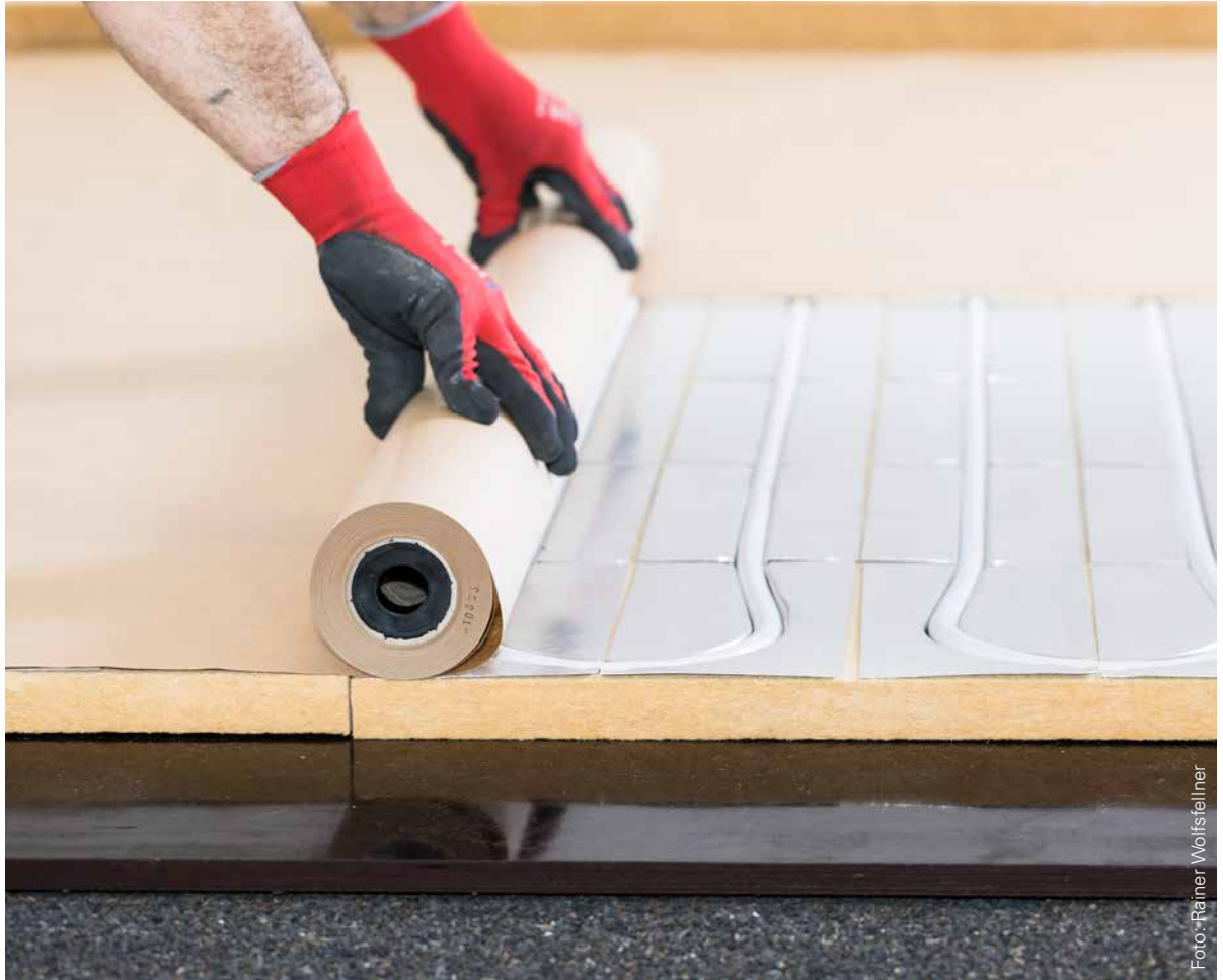
Abb.: System mit Umlenkbleden aus Aluminium
