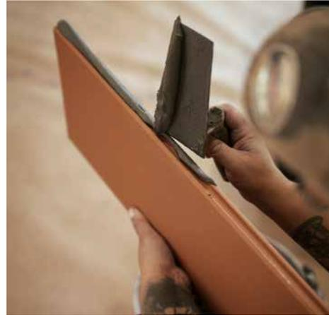
Durch schräges Eintauchen (Ziegelrückseite nach oben) oder mit einer Kelle wird der Kleber gleichmäßig auf den Estrichziegel aufgetragen.
