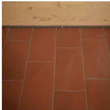
Das Abziehen des überschüssigen Klebers ergibt bei sichtbarer Verlegung das fertige Fugenbild. Anschließend wird der Zementschleier mit einem feuchtem Schwamm entfernt. Dabei dürfen die Fugen nicht überwässert werden.
