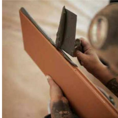
Durch schräges Eintauchen (Ziegelrückseite nach oben) oder mit einer Kelle wird der Kleber gleichmäßig auf den Estrichziegel aufgetragen.
